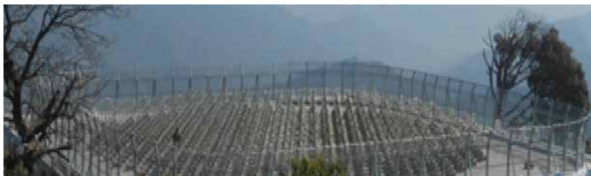
चित्र 59: एंटीना एरे की परिधि के साथ हाल ही में लगाई गई क्लस्टर अव्यवस्थित बाड़ के साथ ASTRAD बिल्डिंग की छत पर ASTRAD एंटीना सरणी।
